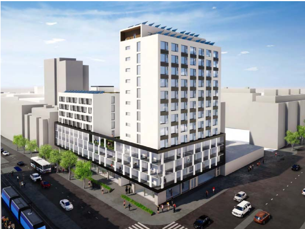
Kuva 1. Tampereen Itsenäisyydenkatu 7–9 sijaitsee Tammelan kaupunginosassa Itsenäisyydenkadun ja Tammelan puistikadun risteyksessä. Ylemmässä kuvassa on esitetty kortteli nykytilanteessa ja alemmassa havainnekuva suunnitellusta rakennuksesta (Havainnekuva: Arkkitehtitoimisto Neva Oy).
